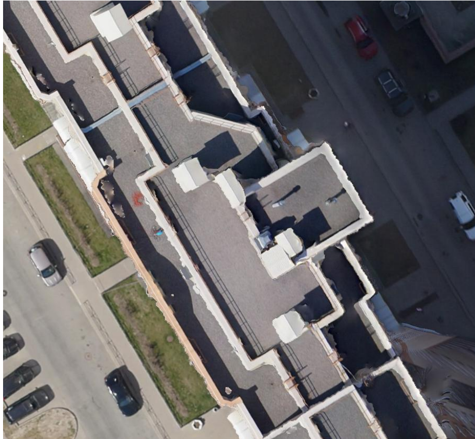
Рис. 1 Искривления крыш зданий
