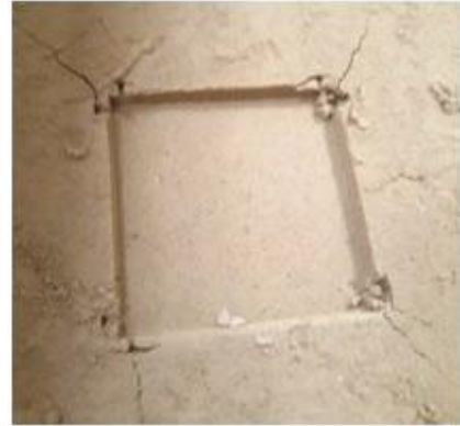
Рис.3 Основание после испытания
